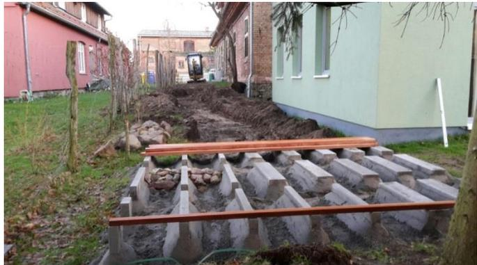
Am 13.12.17 erfolgte der Frostschutz und Unterbau der den Pfad mit einer Kiesverdichtung.
